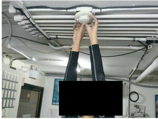
การตรวจสอบอุปกรณ์ในระบบป้องกันและเตือนอัคคีภัย
